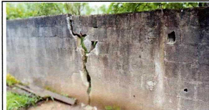
Foto 5: REPARACIÓN DE PAREDES.
