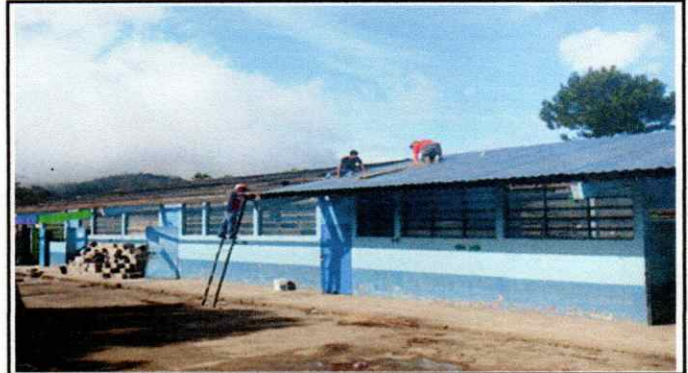
Foto 2: MEJORAMIENTO DE ENTECHADO, SUSTITUYENDO LAMINAS VIEJAS Y DETEREORADAS POR LAMINAS TROQUELADAS
