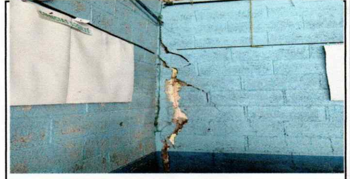
Foto 6: REPARACIÓN DE PAREDES.
