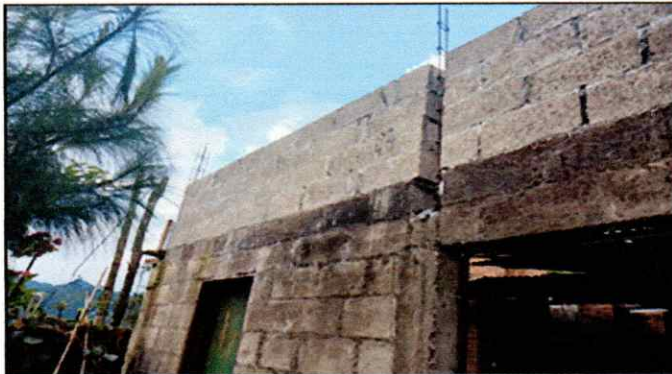
Foto 3: ELEVACIÓN DE PAREDES DE LA COCINA.
