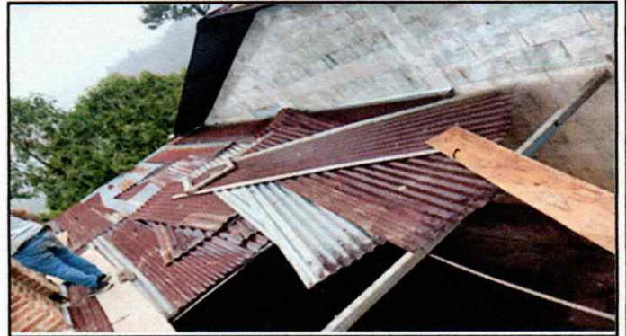
Foto 4: ELEVACIÓN DE PAREDES DE LA COCINA.
