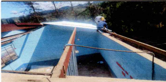
Foto 1: MEJORAMIENTO DE ENTECHADO, SUSTITUYENDO LAMINAS VIEJAS Y DETEREORADAS POR LAMINAS TROQUELADAS
